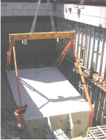
Schwerlast-Traversen 100 t. für den Transport, Verladung und Aufstellung von Cold-Boxen
